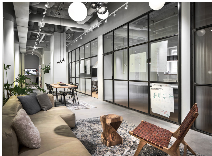
Väggar i kallvalsade profiler med klarlack och linjeglas nedtill.
